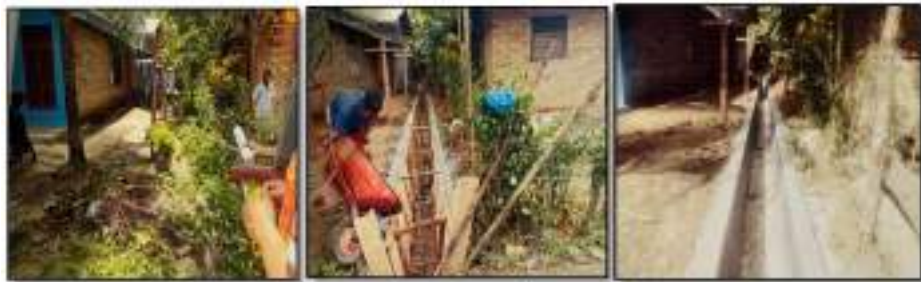
Proses pembenahan saluran drainase dalam rangka pengurangan persentase lingkungan kumuh
